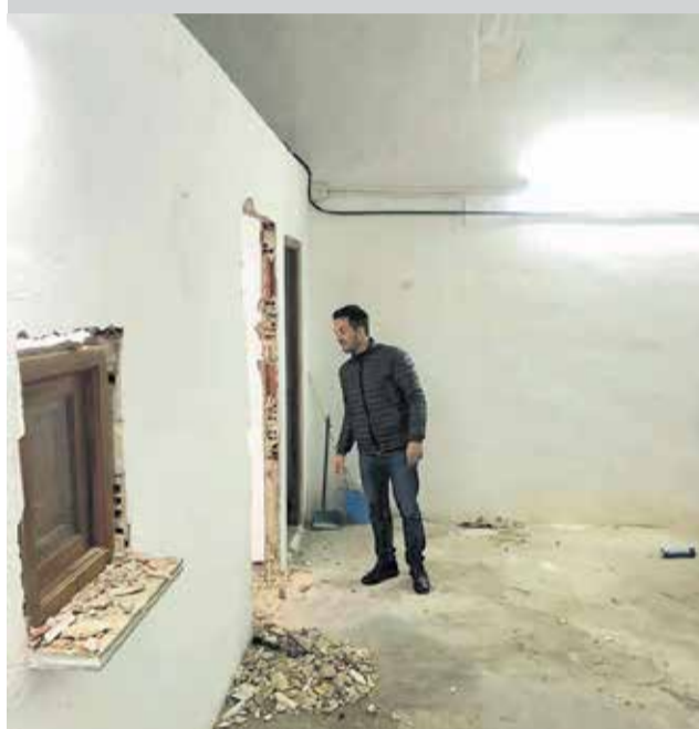
Obras de remodelación en el Hogar del Labrador. / EPDA
