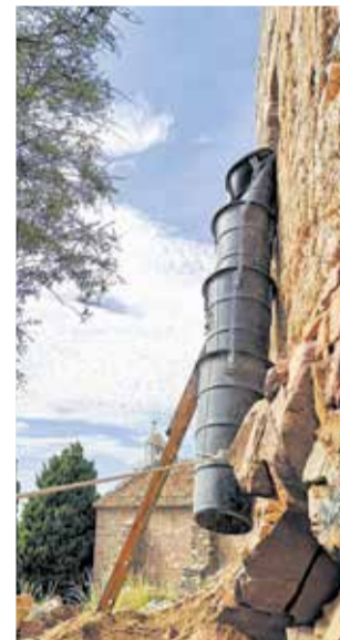
Detall de les obres. / EPDA
