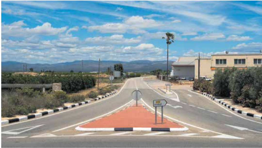
Tram de la carretera CV-339 entre Llíria i Alcublas. / EPDA
