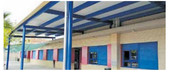
Detalle de la cubierta instalada en el patio. / EPDA
