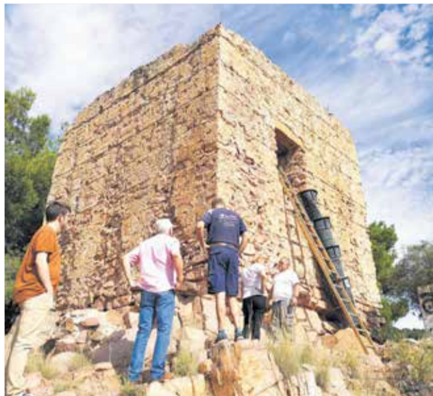
Obres de restauració a la torre. / EPDA
