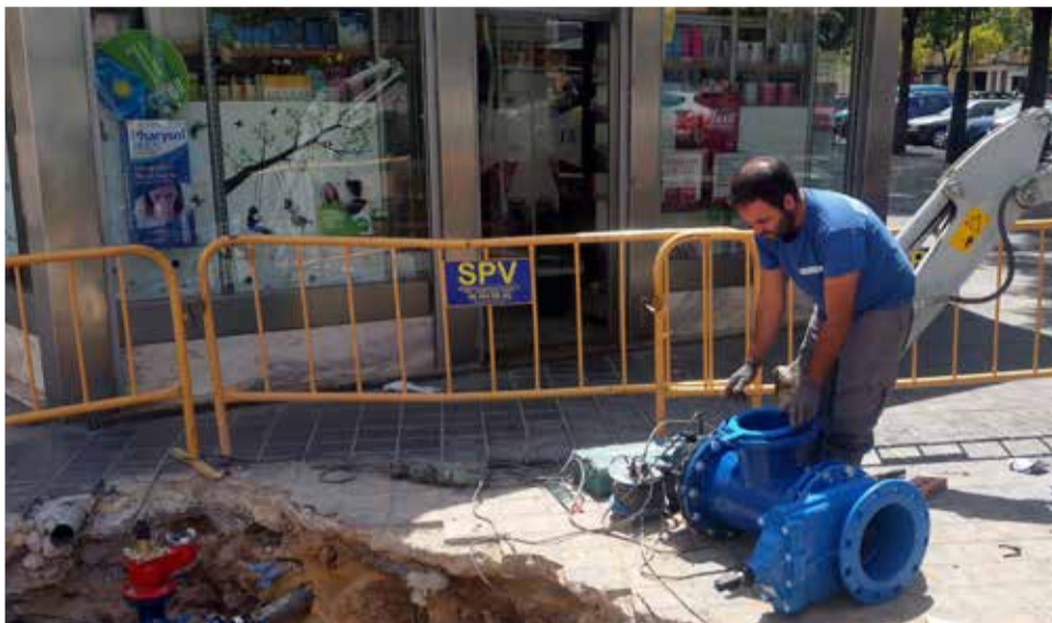
Nuevo sistema hidráulico en Quart de Poblet. / EPDA
