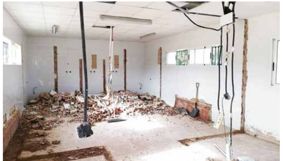
Obres de rehabilitació i millora als vestuaris de la piscina municipal. / EPDA
