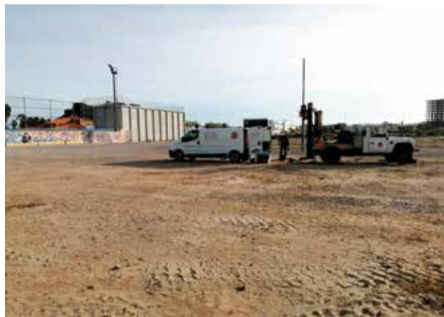
Inicio de las obras del nuevo IES en Canet. / EPDA
