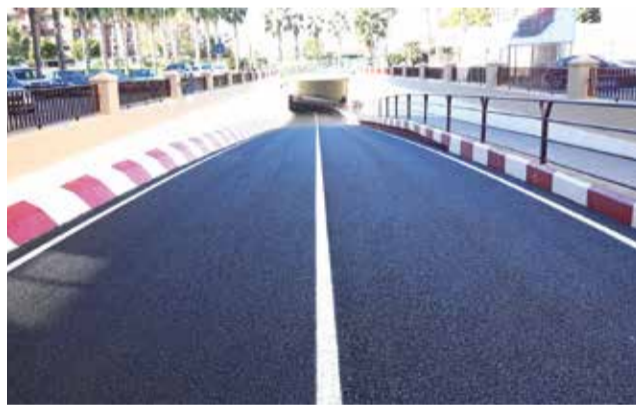
Túnel que conecta Alfatar y Benetússer rehabilitado. / EPDA
