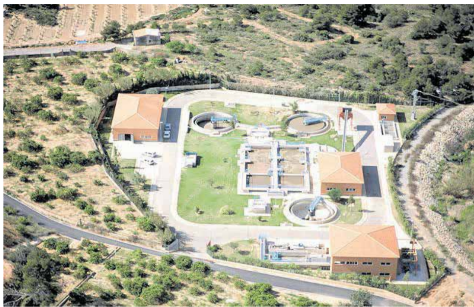
La depuradora de Nàquera, que es troba a la urbanització Bonança. / EPDA
