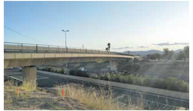
Pont que creua l'autovia. / EPDA
