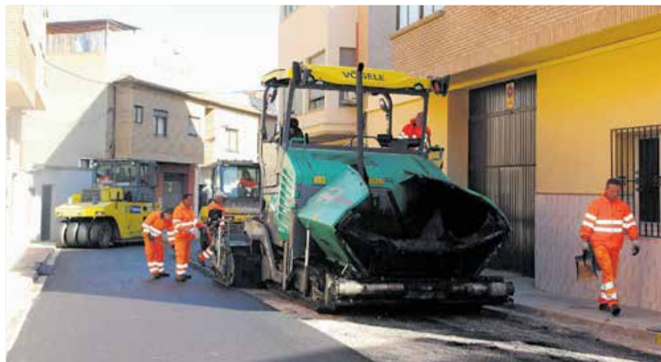
Operarios trabajando en el reasfaltado de las calles de la localidad. / EPDA
