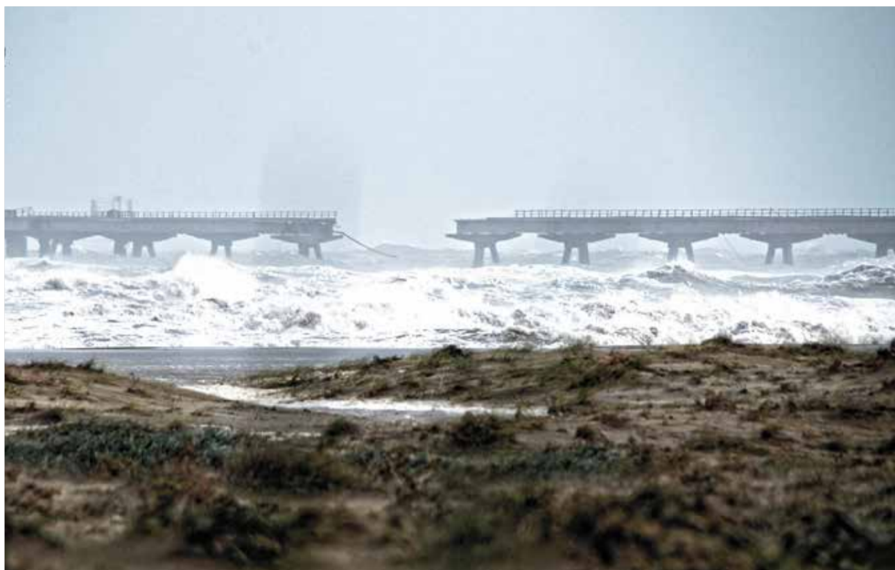
Estado del Pantalán tras el nuevo derrumbe de dos vanos de 30 metros a causa del último temporal. / KIVI OSMA
