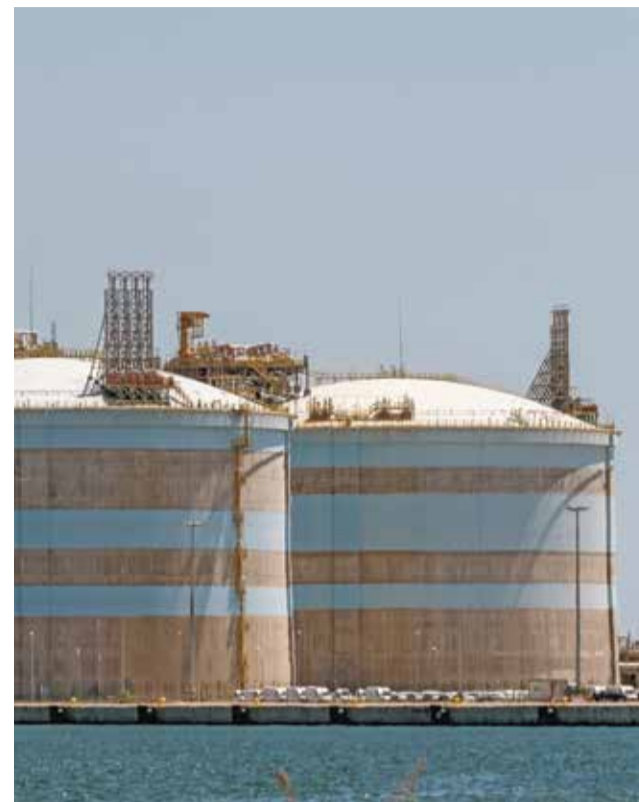
Instalaciones de Saggas en Sagunt. / EPDA
