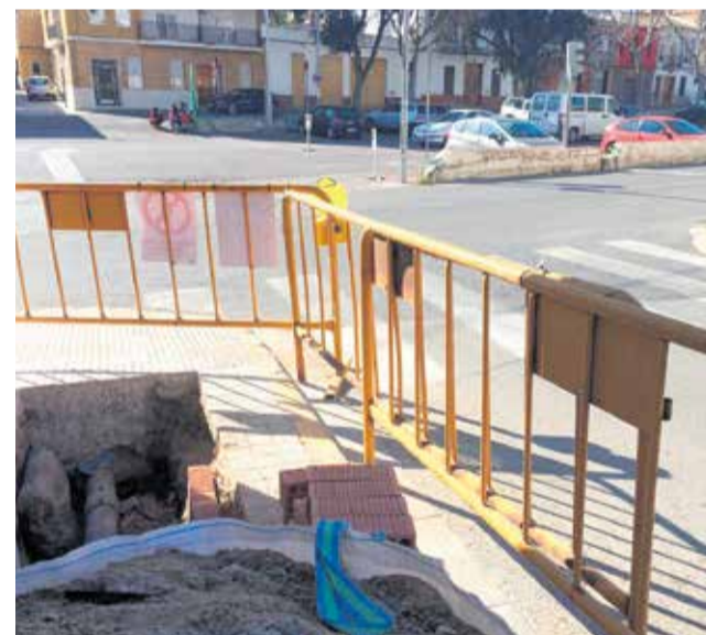
Obras que se están desarrollando en la red de agua / EPDA
