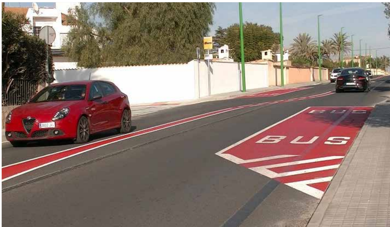
Imagen de las obras finalizadas de la CV-336 de L'Eliana./ EPDA
