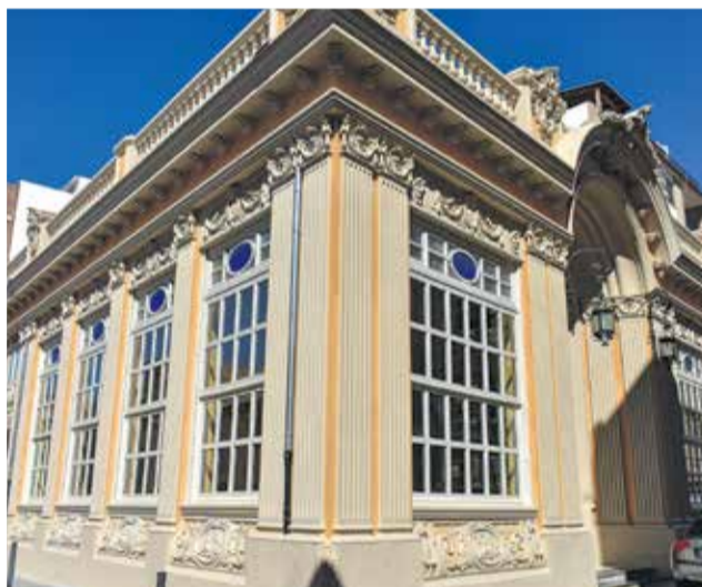
Edificio de la biblioteca municipal de Alfajar. / EPDA
