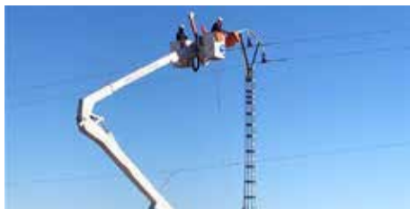
Instalación de protectores. / EPDA
