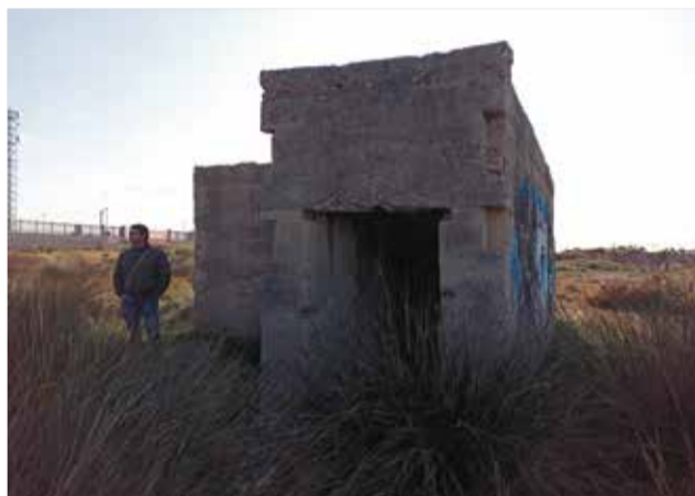
Restos de la batería de costa de Sagunt. / EPDA
