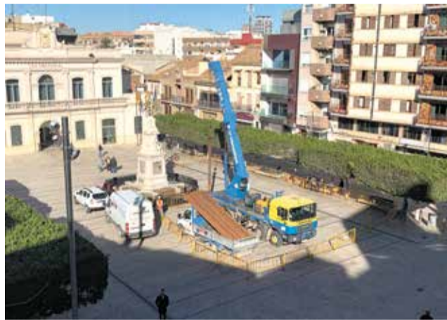
Trabajos de mantenimiento del pozo de la plaza. / EPDA
