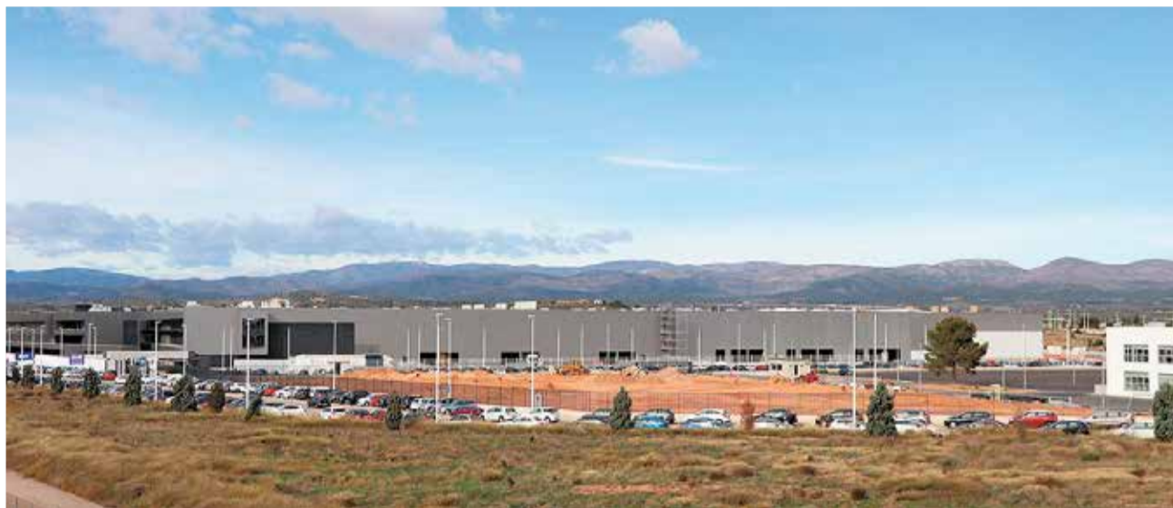
Panoràmica del polígon de Carrasses de Lliria. / EPDA
