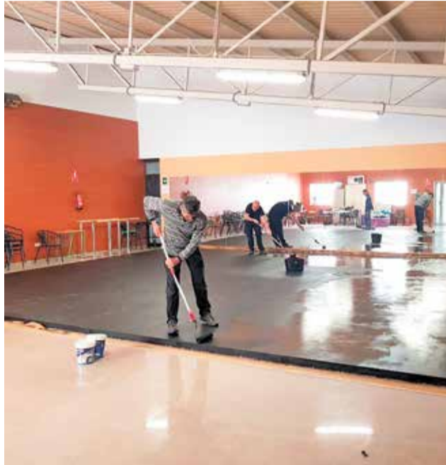
Trabajos de adecuación en la sala de los espejos. / EPDA
