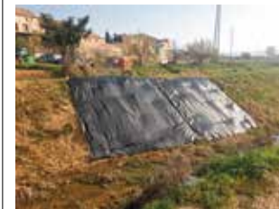
Inicio de las obras. / EPDA
