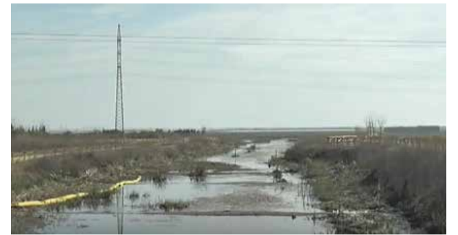
Nuevo Filtro Verde instalado en Silla. / EPDA
