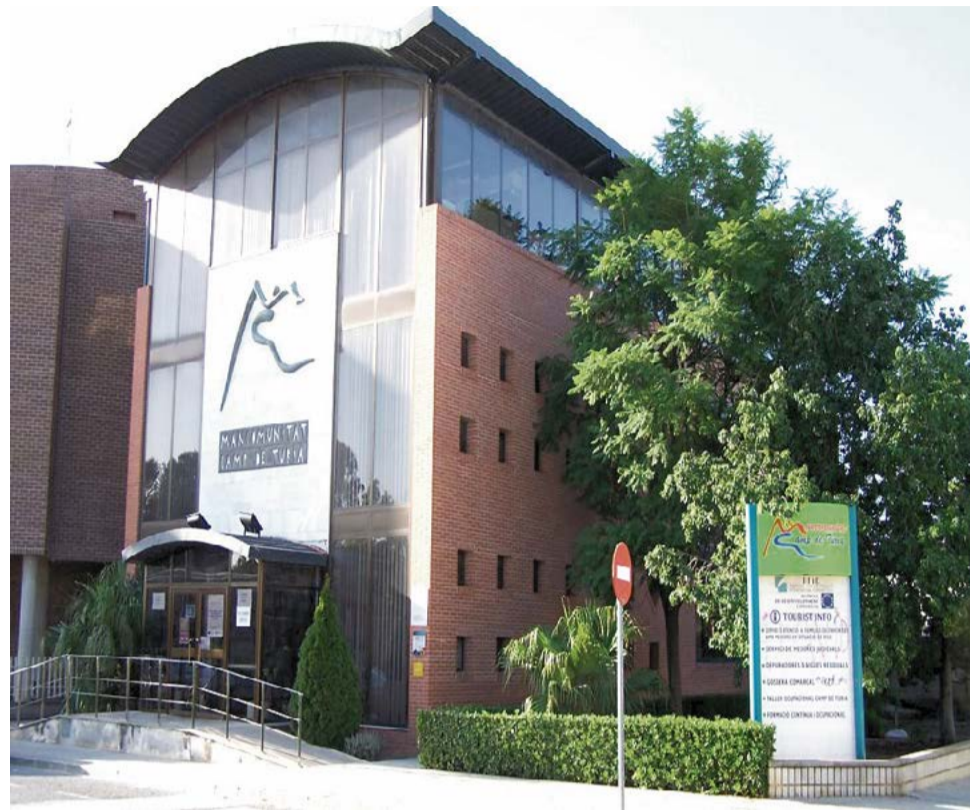
Edificio de la Mancomunitat Camp de Túria ubicado en Lliria. / EPDA
