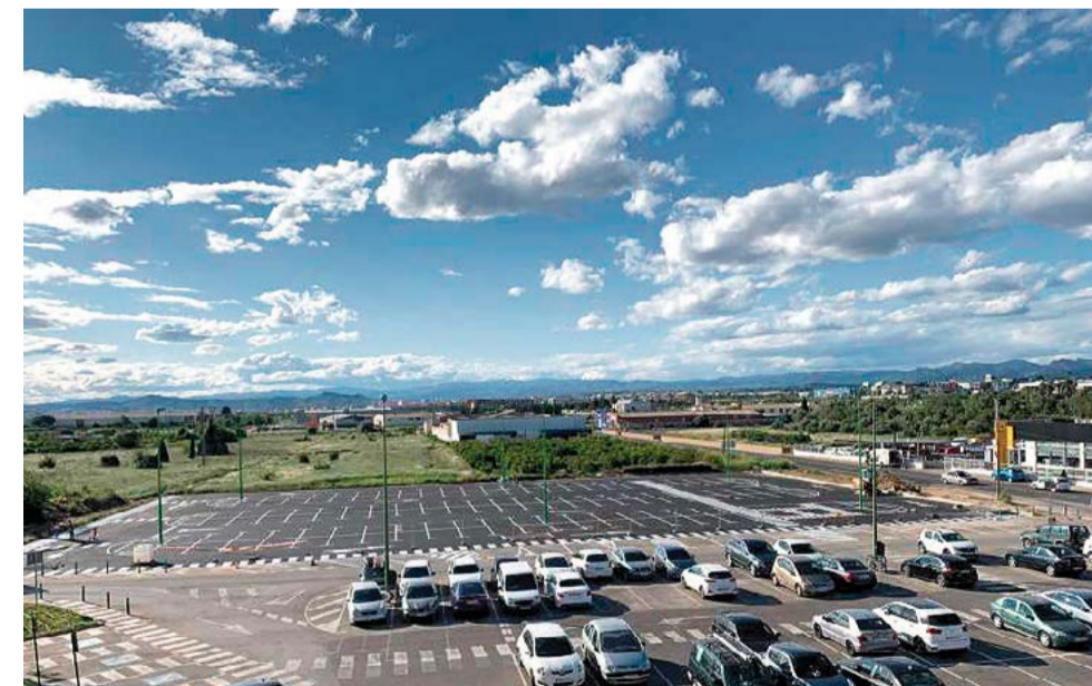
Vista panorámica del aparcamiento recién inaugurado. / EPDA
