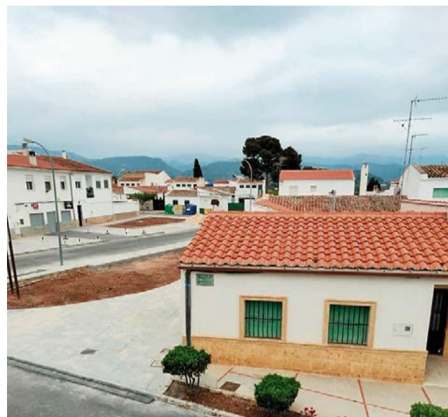
La calle Olocau con las obras concluidas. / EPDA
