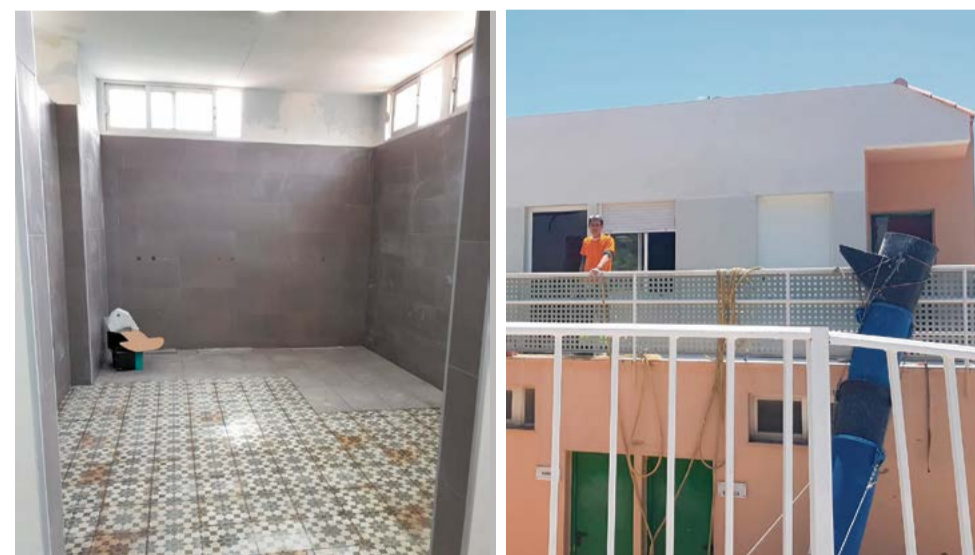
Detalle de las obras que se están desarrollando en el Polideportivo de Olocau. / EPDA
