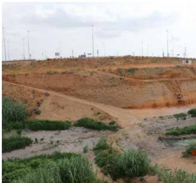
Obras en el barranco de Chiva. / EPDA
