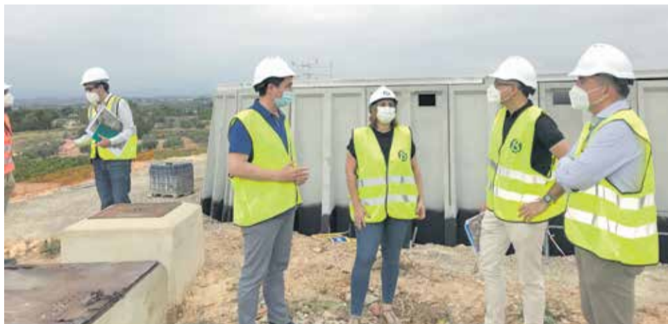
Visita dels tinents d'alcalde Paco Garcia i M a Cruz Garcia a les obres. / EPDA
