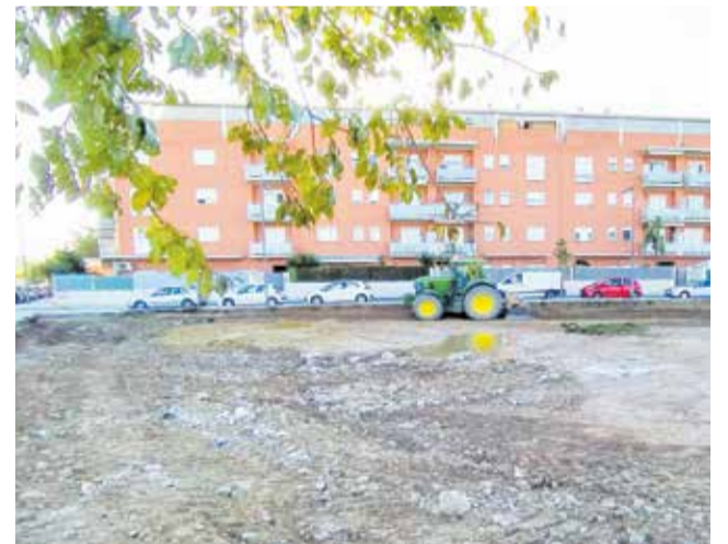
Máquinas trabajando en la construcción del parking. / EPDA
