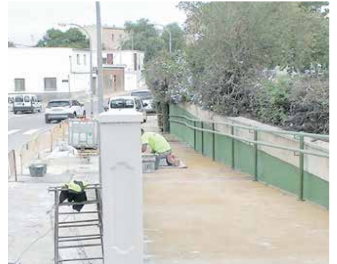
Obras de accesibilidad en L'Eliana. / EPDA.
