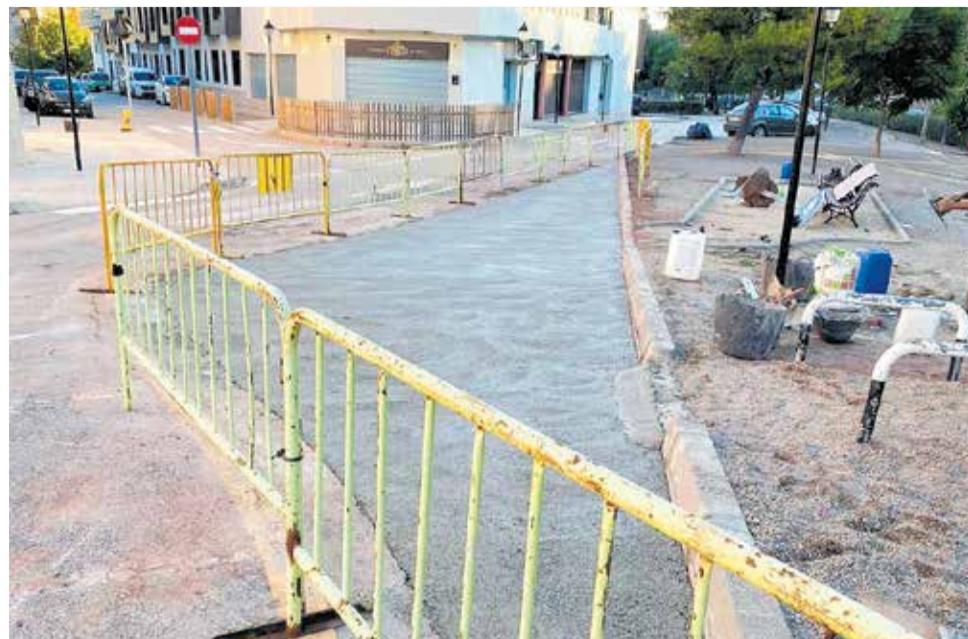
Detalle de las obras que se están desarrollando en la calle. / EPDA
