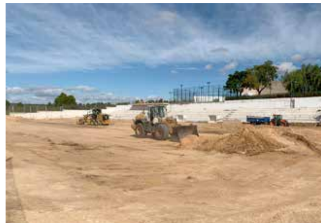
Las palas preparan el terreno para el césped artificial. / EPDA
