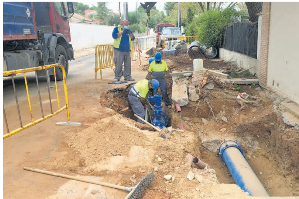
Detalle de las obras de renovación de la canalización de agua potable. / EPDA
