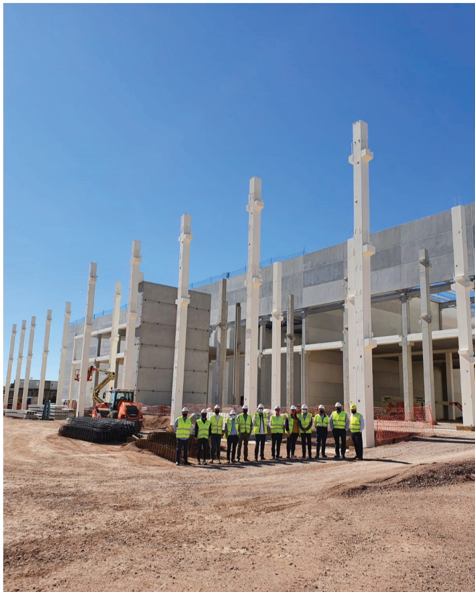
Visita del comité de dirección a las obras. / EPDA
