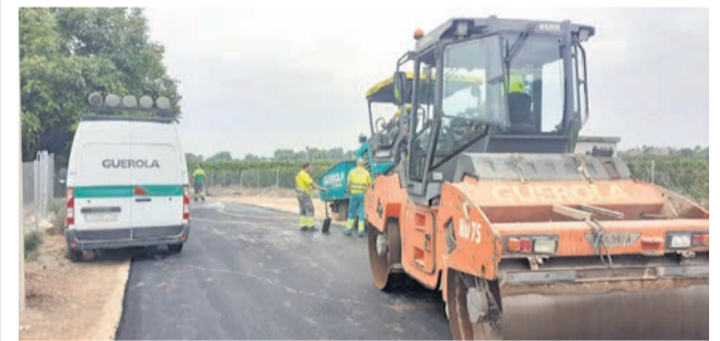
Trabajos de asfaltado en uno de los caminos. / EPDA.
