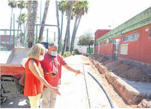
La alcaldesa supervisa las obras de mejora. / EPDA
