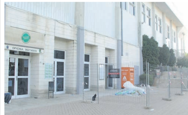
Polideportivo municipal de L'Eliana en obras. / EPDA
