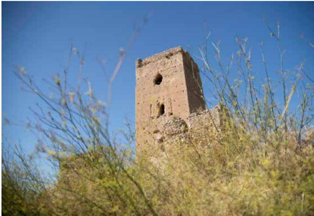
Torre Aledua. / EPDA
