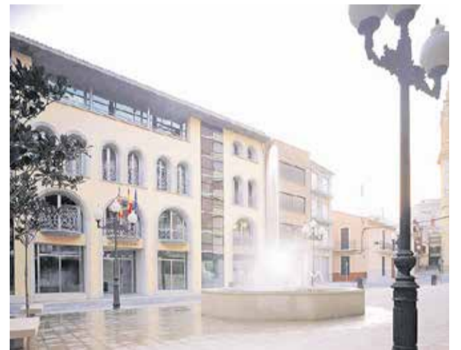
Ayuntamiento de Benaguasil. / EPDA.
