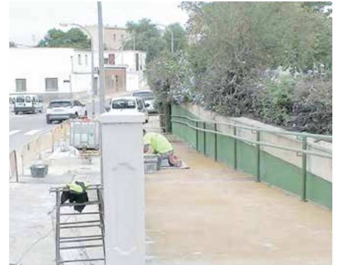
Obras de accesibilidad en L'Eliana. / EPDA.
