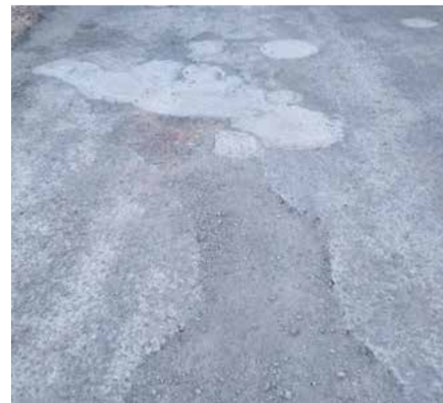
Estado de la calzada / EPDA
