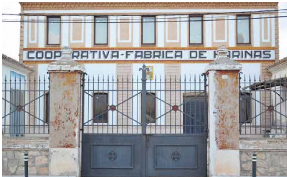
Fachada de la fábrica de las Harinas, de 1930. / EPDA
