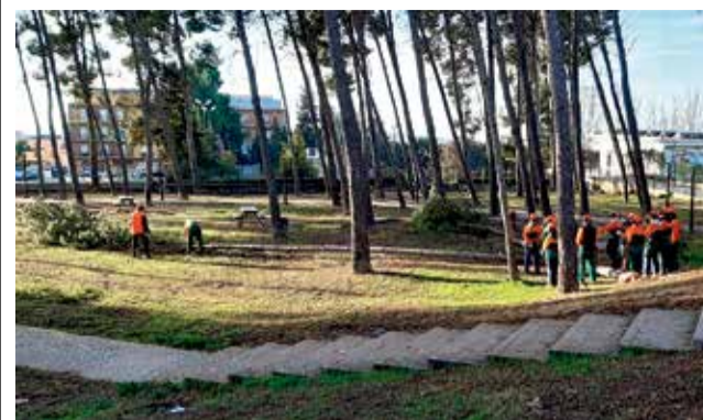
Trabajos de acondicionamiento del parque. / EPDA
