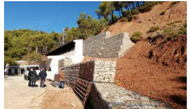
Muro de contención de El Remedio. / EPDA
