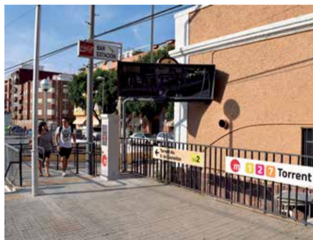
Estación de metrovalencia de Torrent. / EPDA
