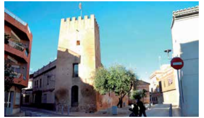
Torre de Albal. / EPDA
