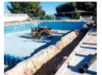
Obra piscina. / EPDA
