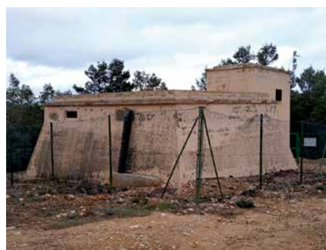
Depósito de agua de Benagéber. / EPDA
