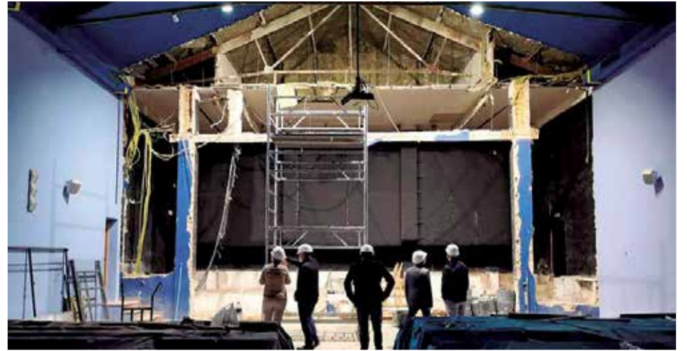
Obras de reforma del nuevo teatro de Xirivella. / EPDA
