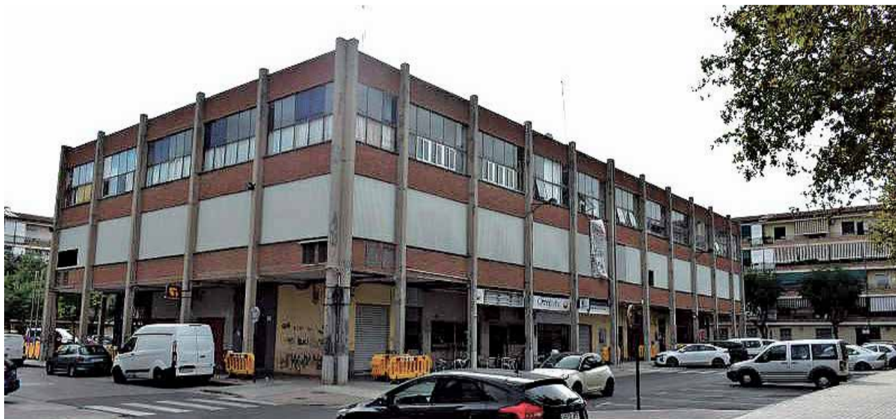
Edificio Meral de Alfatar. / EPDA
