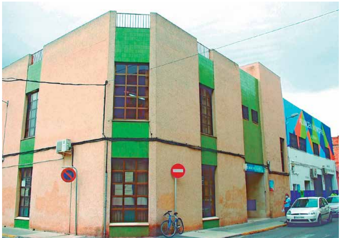
Edificio Tauleta de Alfagar. / EPDA
