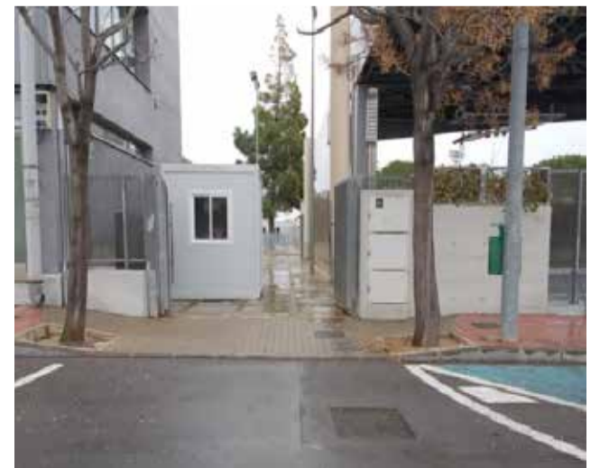
Nuevo control de acceso / EPDA
