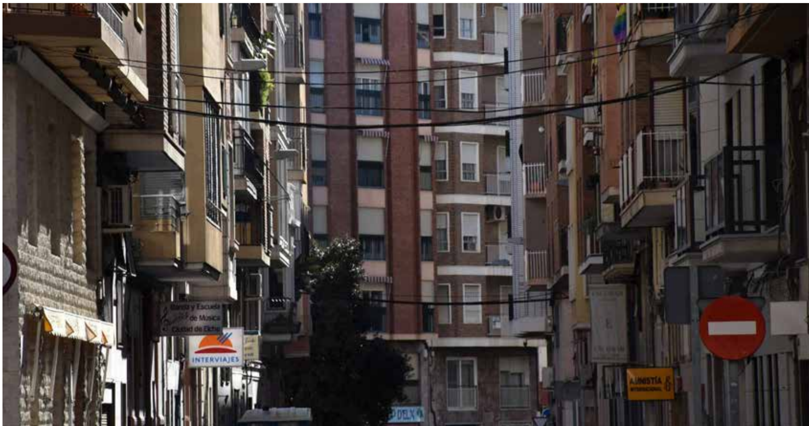
Viviendas de rehabilitación en Elche / EPDA
