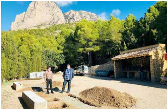
Obras en el área recreativa. / EPDA
