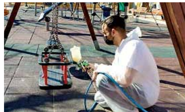
Un operario aplicando la nanopintura. / EPDA
