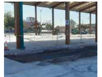
Ejecución de obras / EPDA
