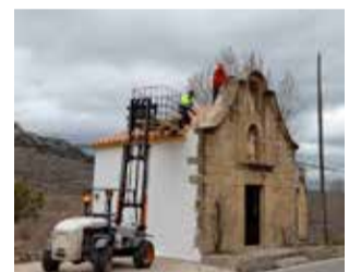
Obras en Forcall / EPDA
