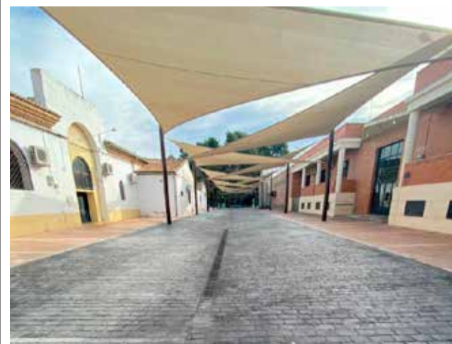
El nuevo adoquinado del patio del mercado. / EPDA
