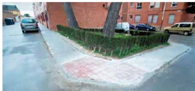
Una de las aceras intervenidas. / EPDA
