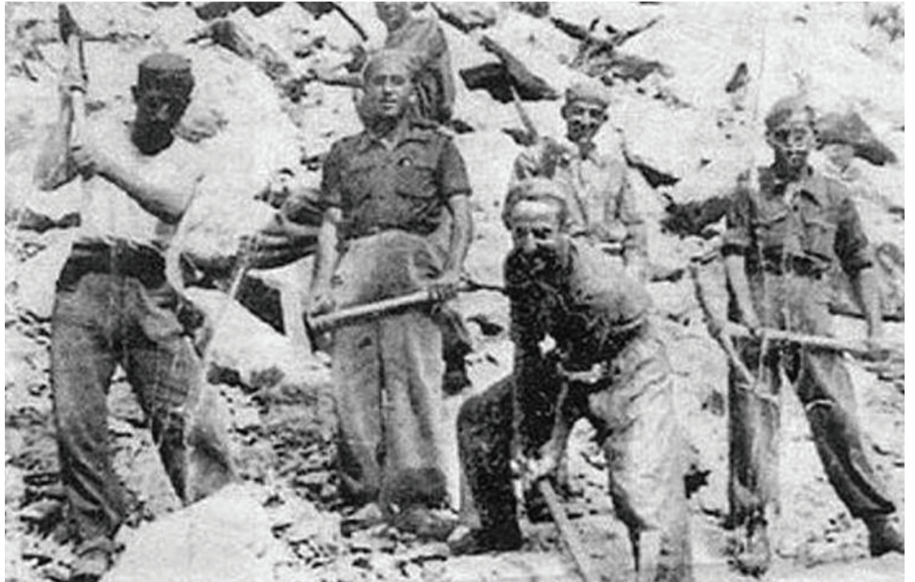
Trabajos en las minas de Almadén. / EPDA
