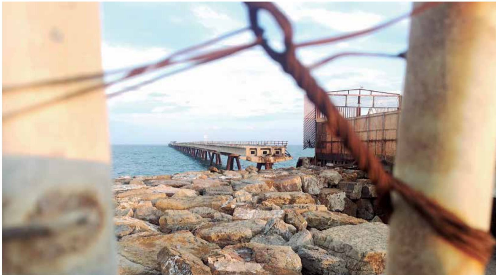
Estado actual del Pantalán. / J.L. LLUESMA
