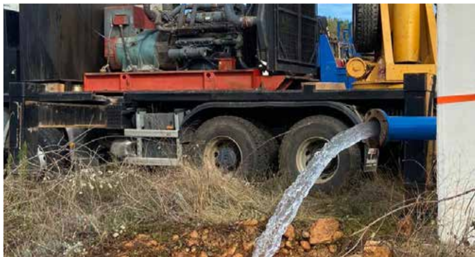
Trabajo de instalación. / EPDA
