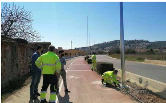
Obras de alumbrado. / EPDA
