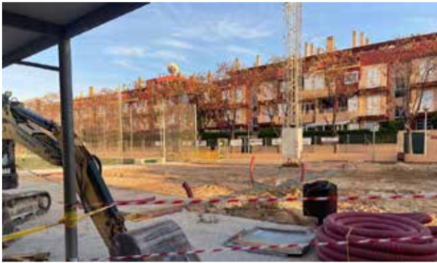
Obras en la parcela. / EPDA
