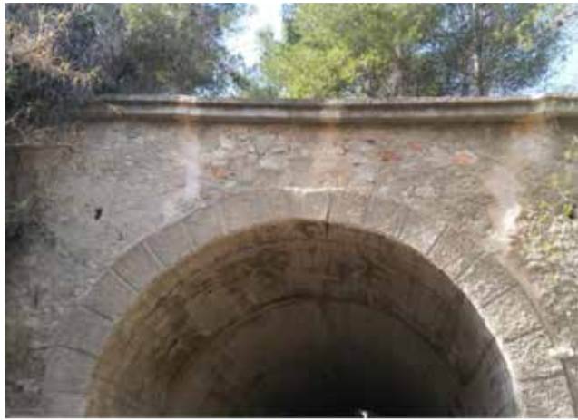
Túnel a reforzar / EPDA
