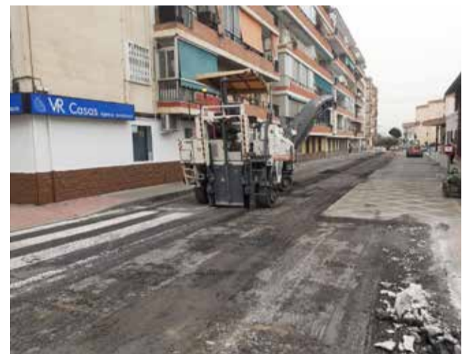
Tareas de asfaltado / EPDA
