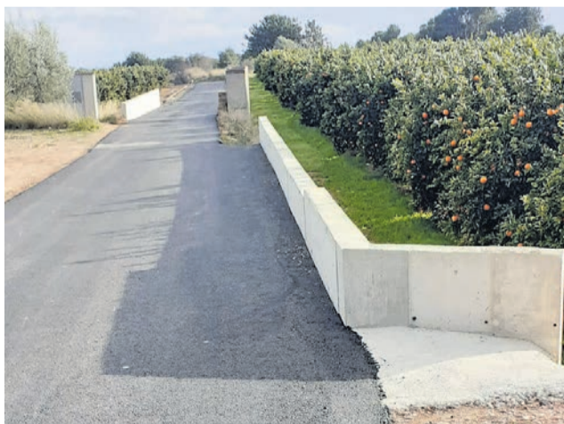
Detalle de una actuación acometida en el municipio. / EPDA
