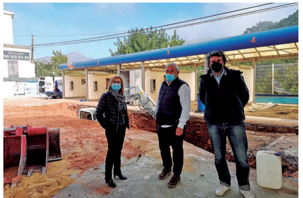
La alcaldesa visita in situ las obras de la nueva gasolinera. / EPDA
