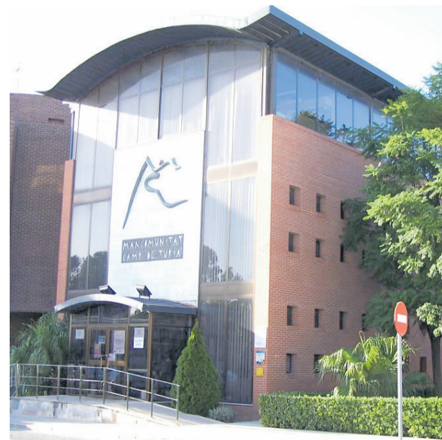
Sede de la Mancomunitat Camp de Túria. / EPDA
