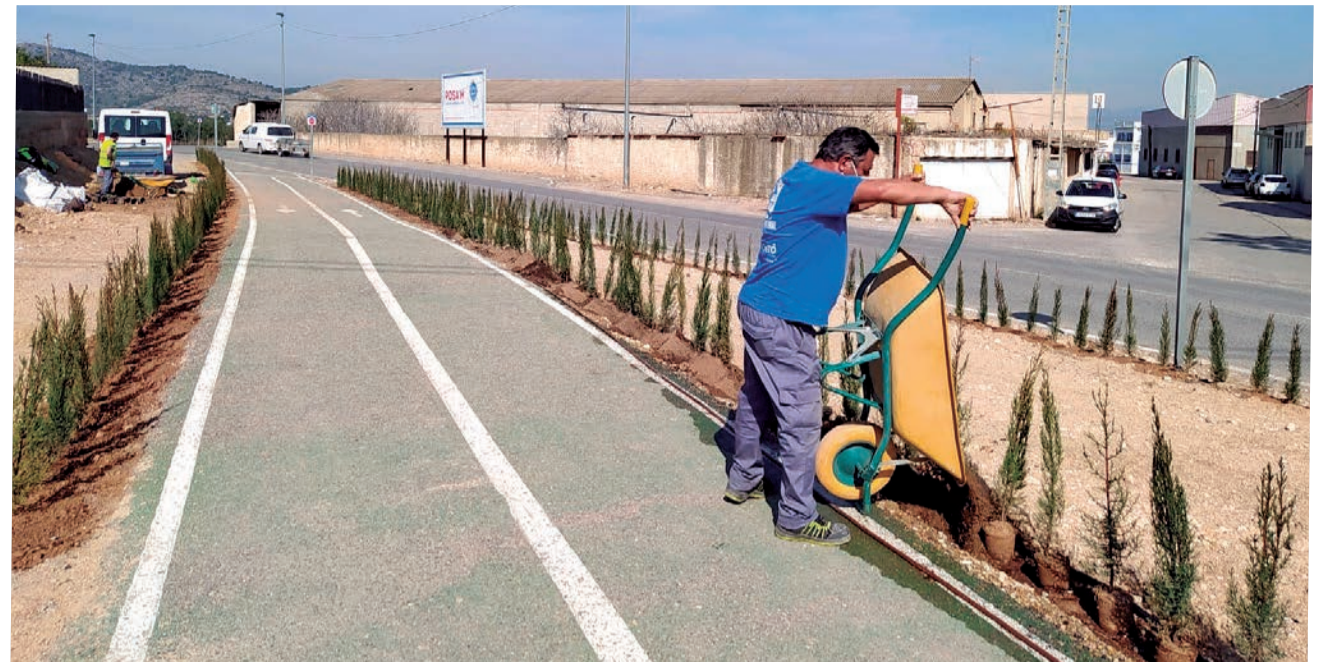
Un operario realizando trabajos en la entrada a Benaguasil por la calle Retorta. / EPDA
