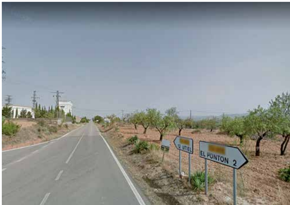
Encuentro entre el tramo ya acondicionado y el del Azagador y Utiel / EPDA
