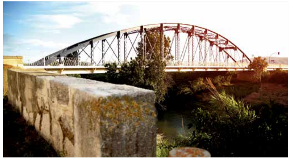
Puente de Hierro. / EPDA
