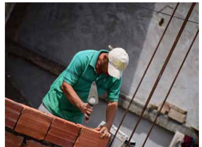
Tareas de albañilería / EPDA
