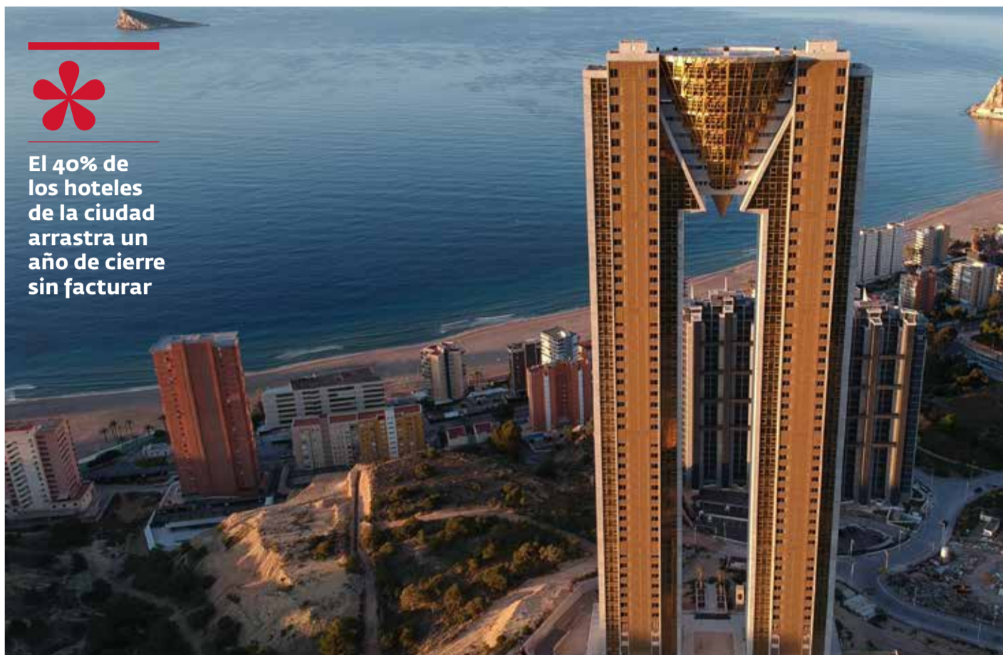
Edificio Intempo / EPDA
