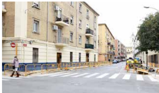
Obres a Paiporta. / EPDA
