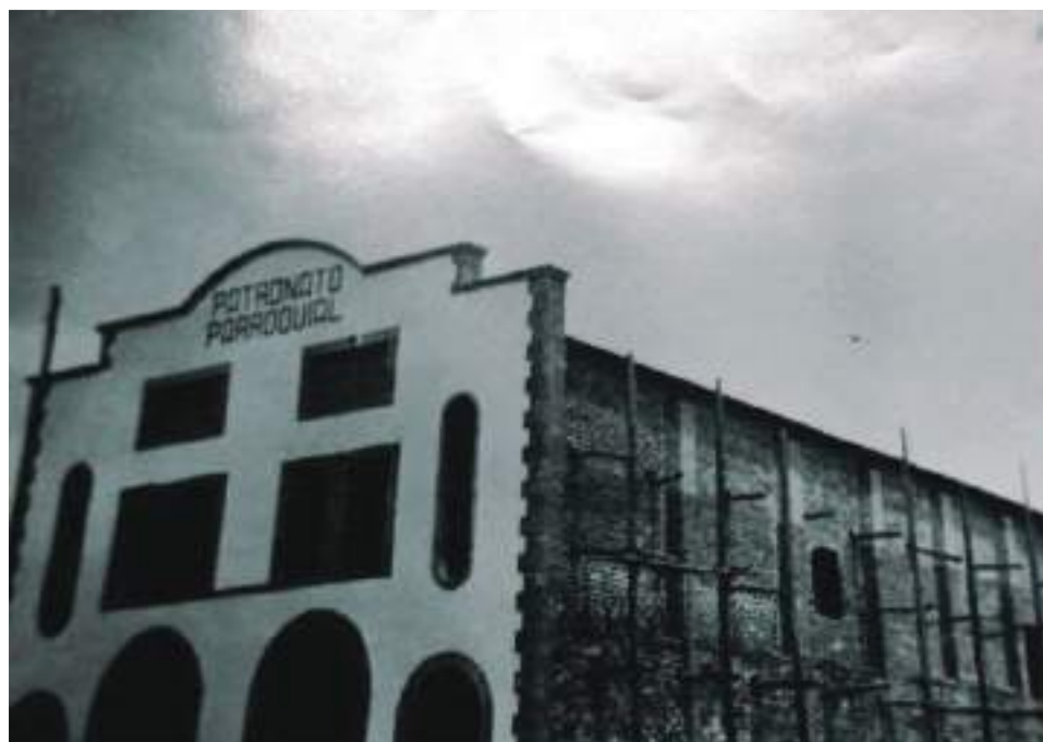
Antiguo edificio en Villar del Arzobispo/ EPDA
