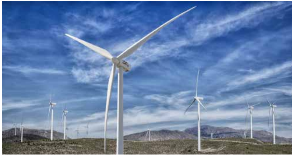
Parque eólico. / EPDA
