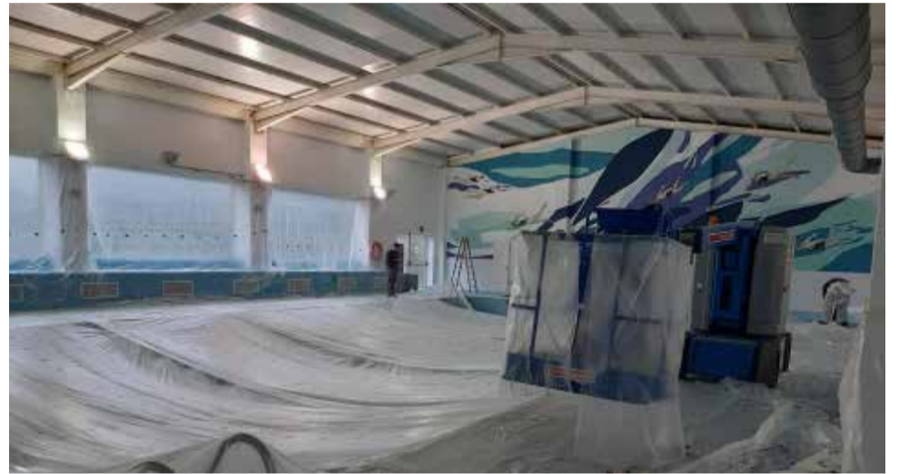
La piscina cubierta en obras / EPDA
