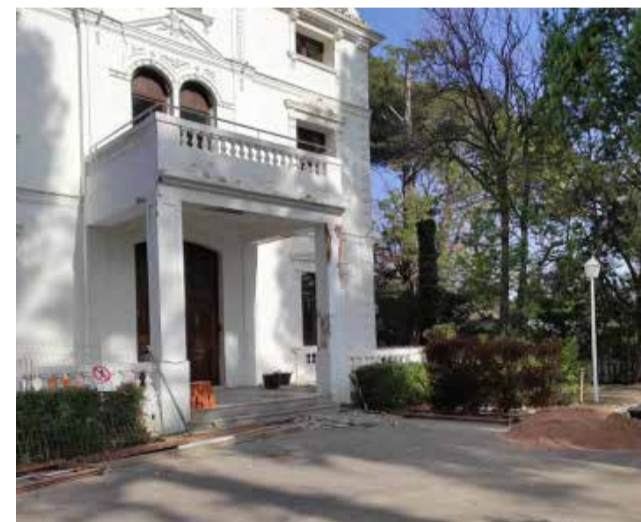
Han comenzado las obras en el edificio / EPDA
