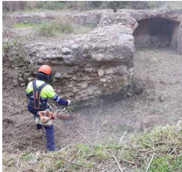
Treballs de desbrossament / EPDA
