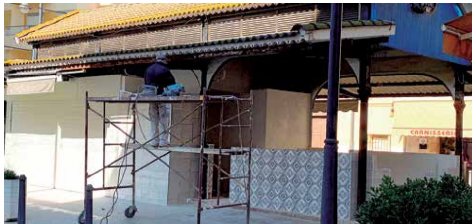
Rehabilitación Mercado Municipal. / EPDA
