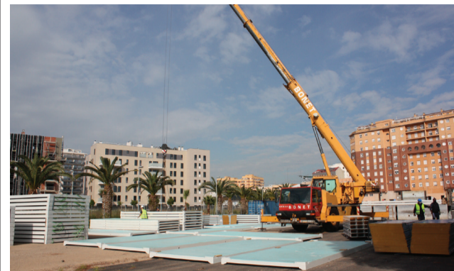
Muntatge de les aules. / EPDA
