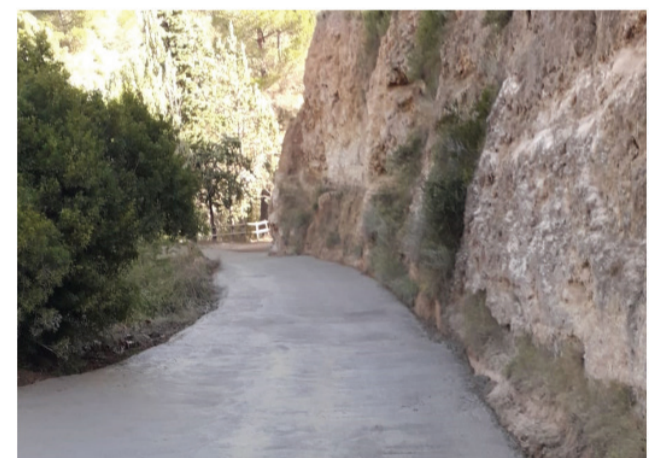
Trabajos finalizados en el camino. / EPDA
