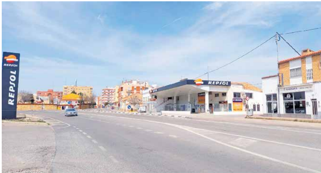
Tramo del acceso Este a Utiel. / EPDA
