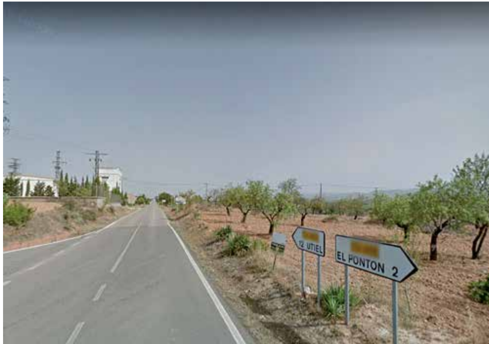
Encuentro entre el tramo ya acondicionado y el del Azagador y Utiel / EPDA
