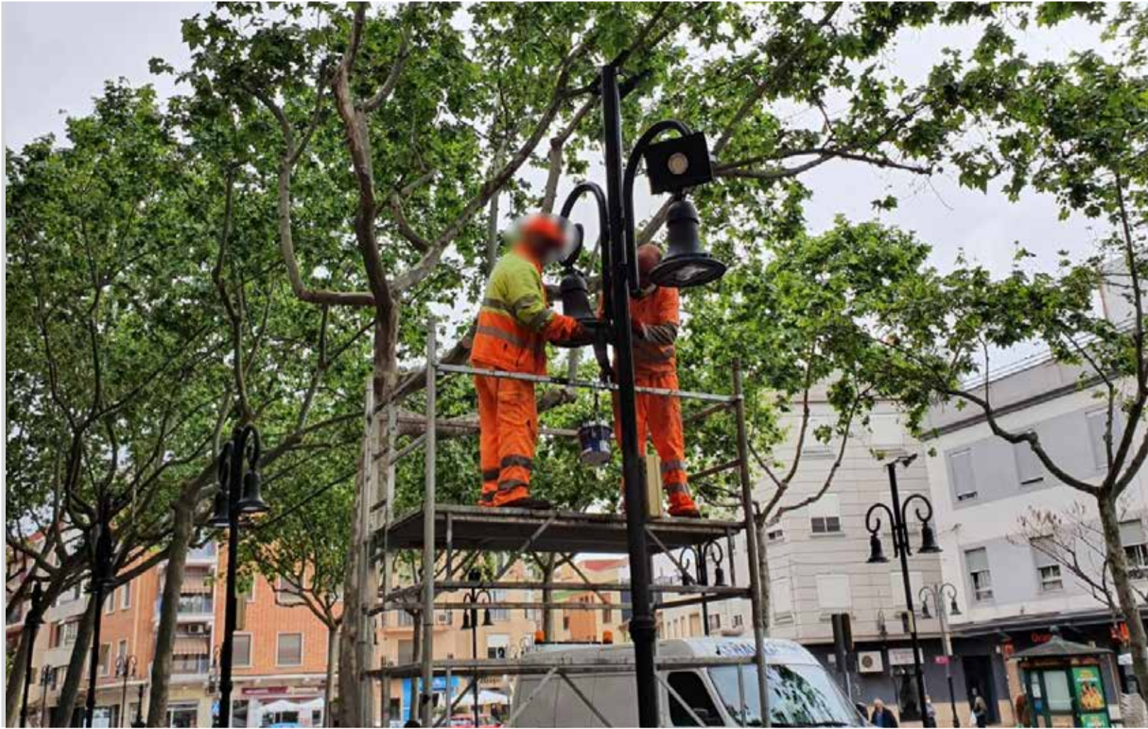
Dos usuarios colocando la nueva iluminación en Aldaia. / EPDA
