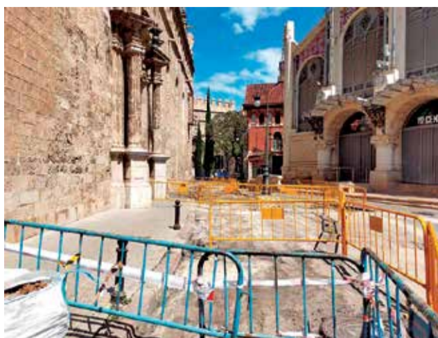
Intervención junto al Mercado Central. / EPDA
