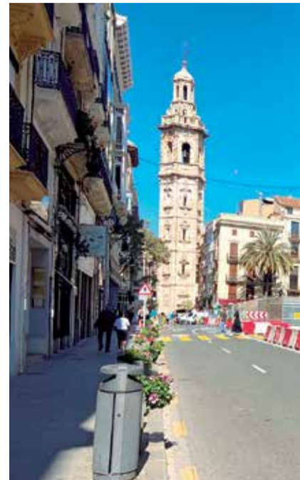
Obras en la calle de la Paz, a su lleg
