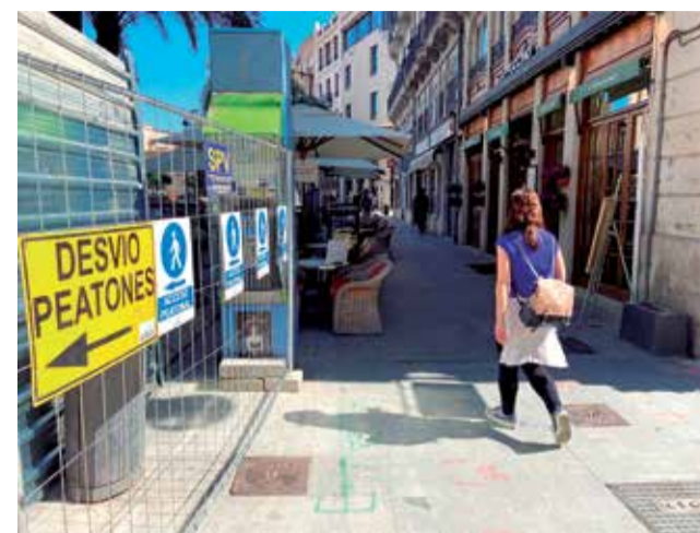
Vallado en el acceso a la Plaza de la Reina. / EPDA
